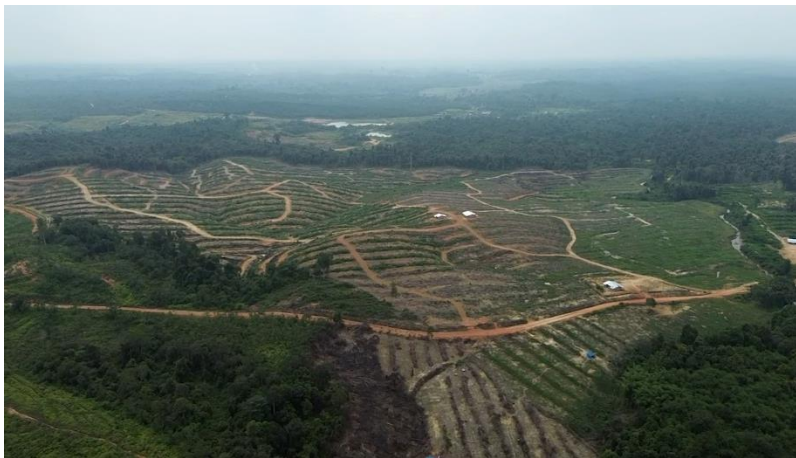
Gambar 14. Drone shot Areal pembukaan lahan kelapa sawit
