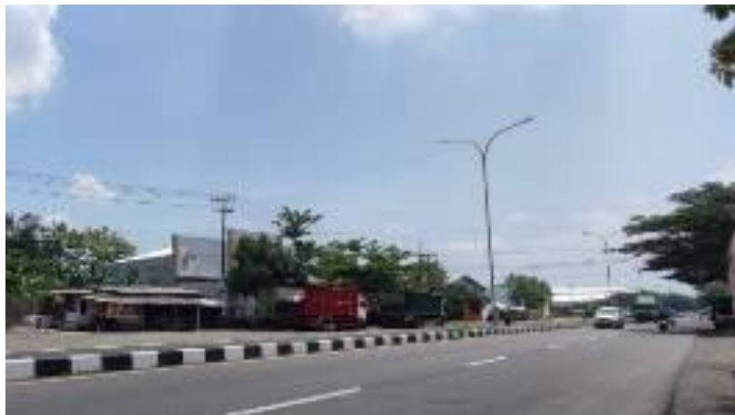
Gambar 9. PJU Ring Road Surakarta Sumber Gambar: Dokumentasi Pribadi, 2025
